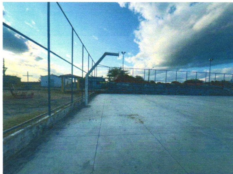
Foto 02 – PISO EM CONCRETO 20 MPA PREPARO MECÂNICO, ESPESSURA 7CM. AF_09/2020
