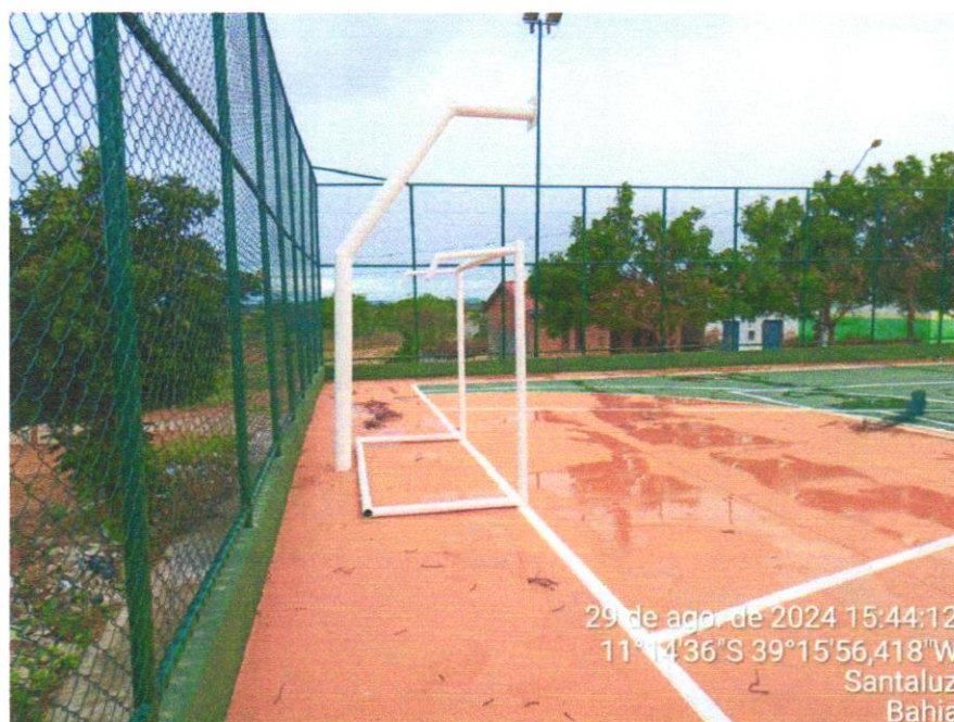
Foto 06 - ALAMBRADO PARA QUADRA POLIESPORTIVA, ESTRUTURADO POR TUBOS DE AÇO GALVANIZADO, (MONTANTES COM DIÂMETRO 2", TRAVESSAS E ESCORAS COM DIÂMETRO 1 ¼ ), COM TELA DE ARAME GALVANIZADO, FIO 10 BWG E MALHA QUADRADA 5X5CM (EXCETO MURETA). AF_03/2021
