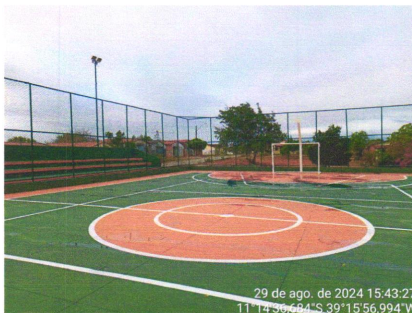
Foto 08 – PINTURA DE PISO COM TINTA ACRÍLICA, APLICAÇÃO MANUAL, 2 DEMÃOS, INCLUSO FUNDO PREPARADOR. AF_05/2021
